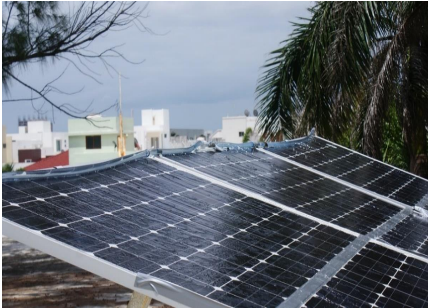
Sistema de recirculación de agua sobre la superficie de los PF de la UV Campus Coatzacoalcos
